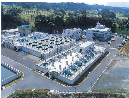
大多喜浄水場
