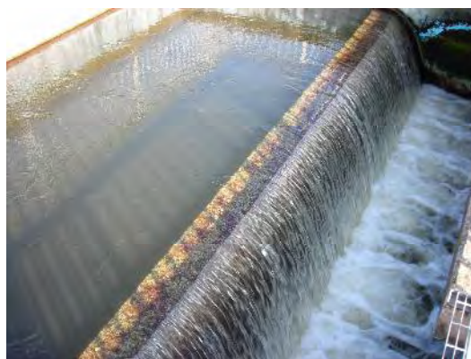
浄水場着水井(原水:浄水場入口)
