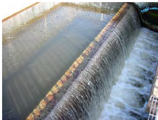
浄水場着水井(原水:浄水場入口)
