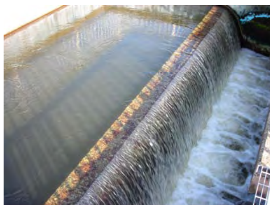
浄水場着水井(原水:浄水場入口)
