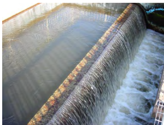
浄水場着水井(原水:浄水場入口)
