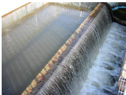
浄水場着水井(原水:浄水場入口)
