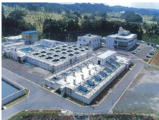
大多喜浄水場
