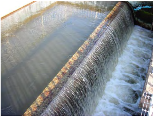
浄水場着水井(原水:浄水場入口)
