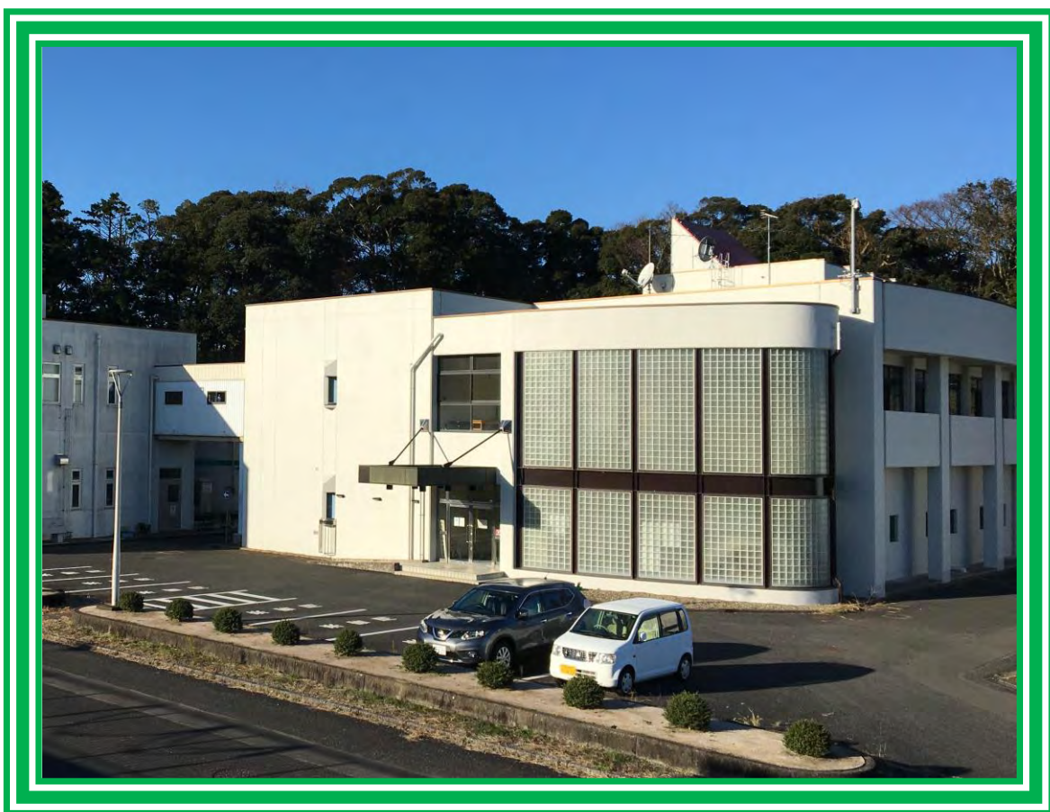
大多喜浄水場 管理本館
