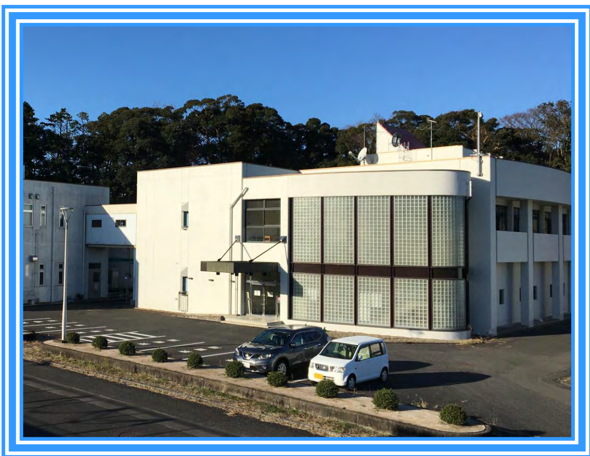
大多喜浄水場 管理本館
