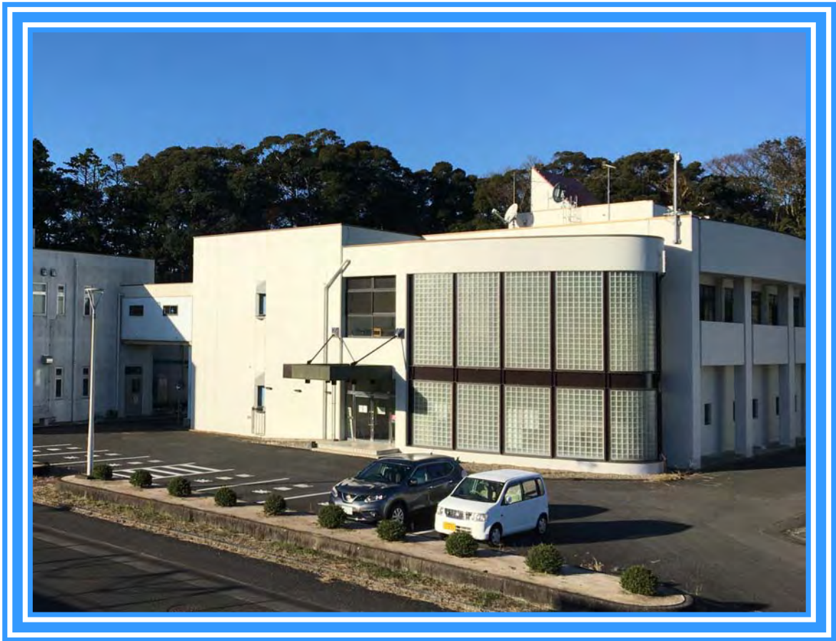
大多喜浄水場 管理本館
