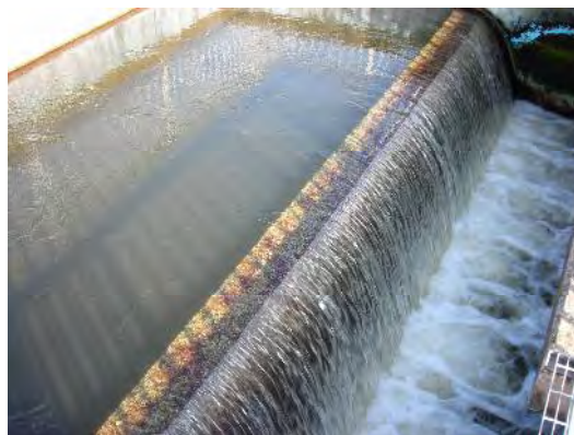
浄水場着水井(原水:浄水場入口)
