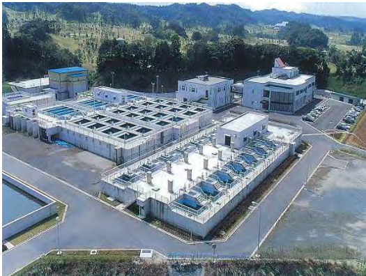
大多喜浄水場
