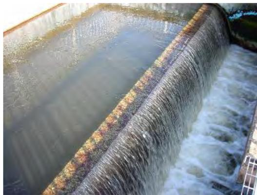
浄水場着水井(原水:浄水場入口)
